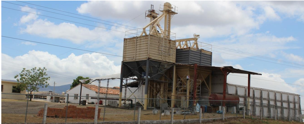
IMAGEN N° 90. ZONA INDUSTRIAL A LAS AFUERAS DE LA CABECERA MUNICIPAL.
