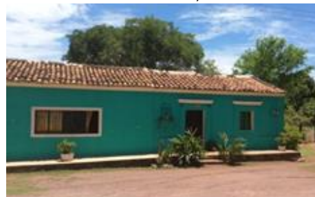
IMAGEN N° 71. VIVIENDA, JALPA N° 2.
