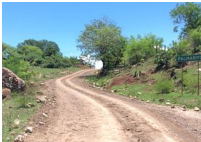
IMAGEN N° 37. TERRACERÍA PALMARITO LAS CALDERAS.
